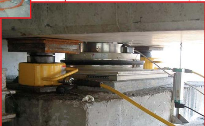
I sollevamenti sincronizzati delle strutture sono una delle principali attività dell'azienda. Riguardano sia opere esistenti, per la manutenzione degli appoggi, sia opere di nuova realizzazione che prevedono il sollevamento quale metodo di costruzione.
