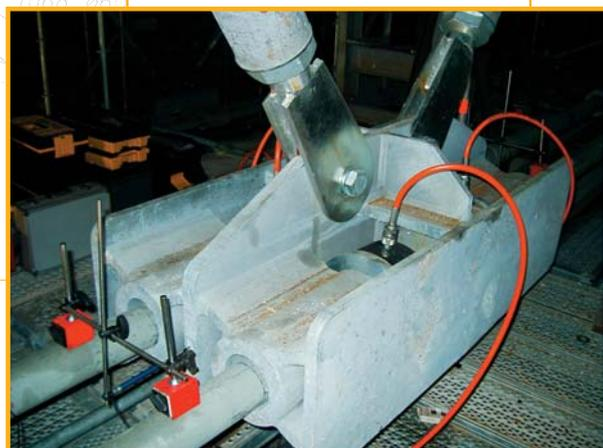
I tensionamenti vengono effettuati con tecniche e attrezzature idrauliche o meccaniche e possono riguardare sistemi di precompressione a trefoli e a barre, pendini, stralli e tiranti di ancoraggio.
