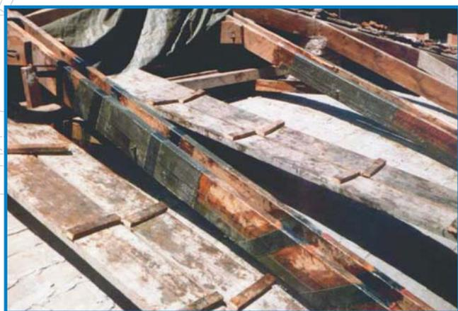
Rinforzo delle capriate lignee di una copertura. I materiali compositi si applicano perfettamente su supporti in legno. Sono stati rinforzati con tessuti in fibra di carbonio tutti gli elementi portanti della copertura: rinforzo a trazione dei tiranti centrali, rinforzo a flessione e a taglio delle travi in legno, frettaggio del nodo di connessione.
